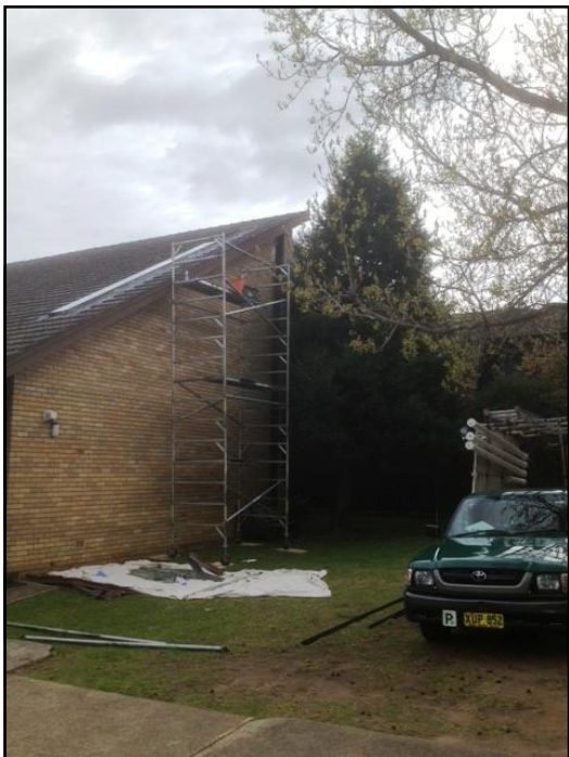
Baznīcas jumta remontes
